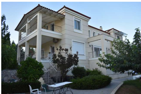
Εικ. 6. Νότιοδυτική όψη στην θέα
