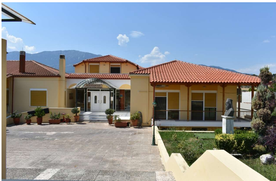
Εικ. 20. Όψη στο δρόμο (ανατολική)
