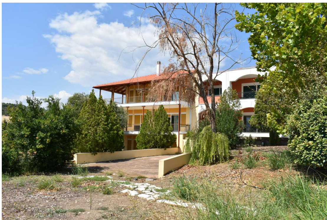
Εικ. 22. Όψη στο δρόμο
